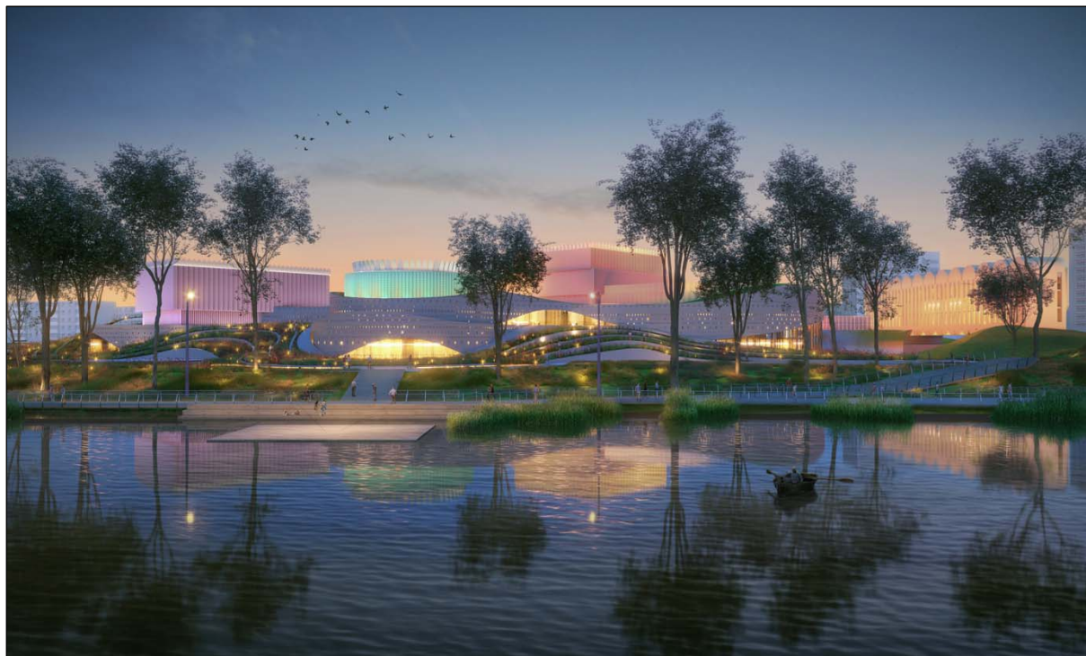
Архитектурная концепция театра Камала. Консорциум бюро Megabudka, ZARF и FORM. 2022 г. Изображение авторов.
